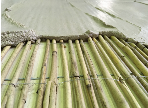
02 Auftrag der ersten Putzschicht (CT Probe) auf eine Holzplatte mit Schilfrohr als Putzträger
