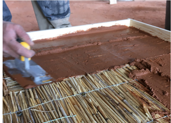
03 Auftrag der ersten Putzschicht (SU Probe) auf eine Schilfrohrplatte (mit Thermoelementen ausgestattet)
