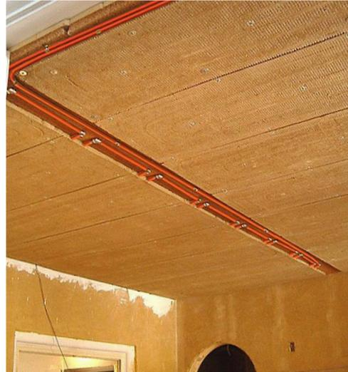
10 In diesem Holzhaus in Italien (2005) wurden WEM Klimaelemente an den Decken montiert
