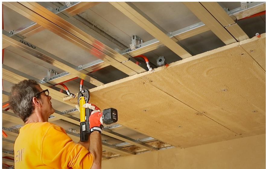
07 Die Klimatelemente wurden an die Deckenkonstruktion geschraubt und die Rohrleitungen durch Verpressen miteinander verbunden
