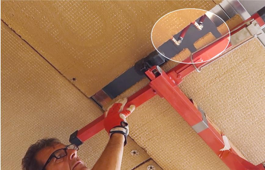
06 Vorgefertigt ausgefräste Lehmplatten nehmen die Rohrverbindungen der WEM Klimatelemente auf und sorgen für eine durchgehende Fläche zum Verputzen
