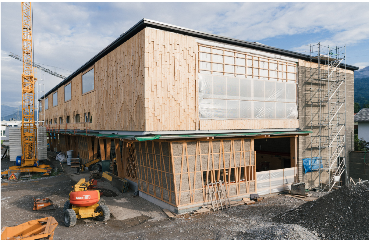
11 ERDEN Werkhalle – ausgeführt in einer Stampflehm-Massivholz-Hybridbauweise
