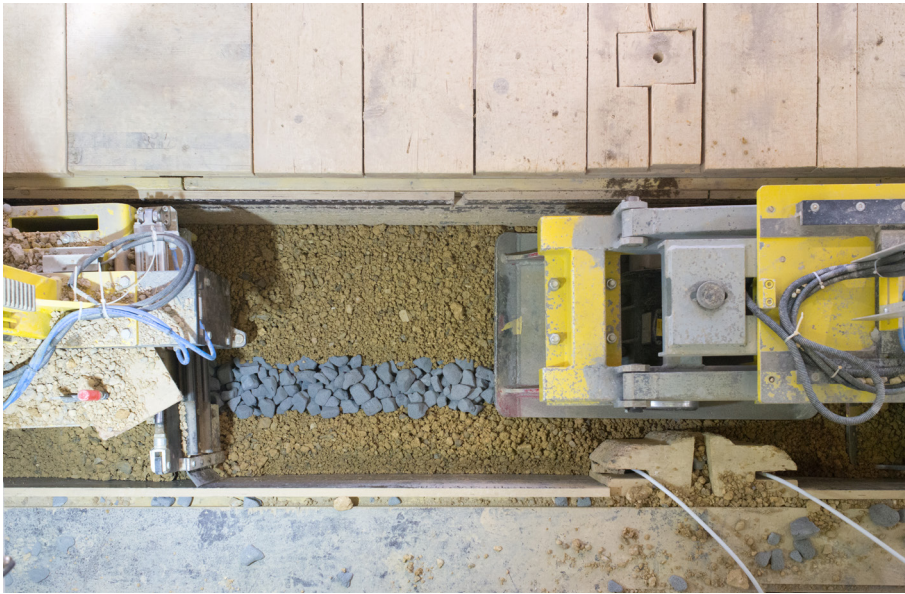
03 Stampfgang: Verdichtung der in die Schalung eingebrachte Stampflehm Mischung
