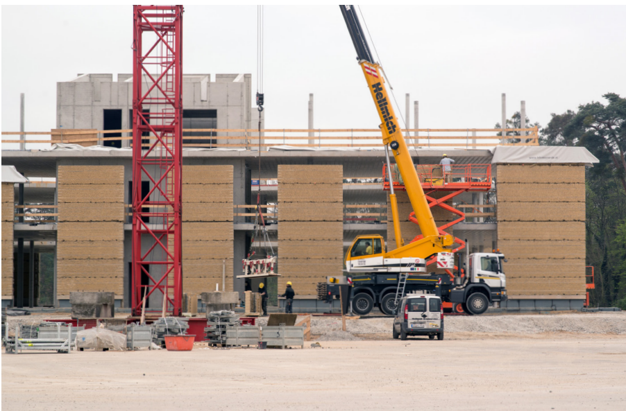
08 Versetzte Stampflehmelemente Aussenfassade – Alnatura Campus Darmstadt
