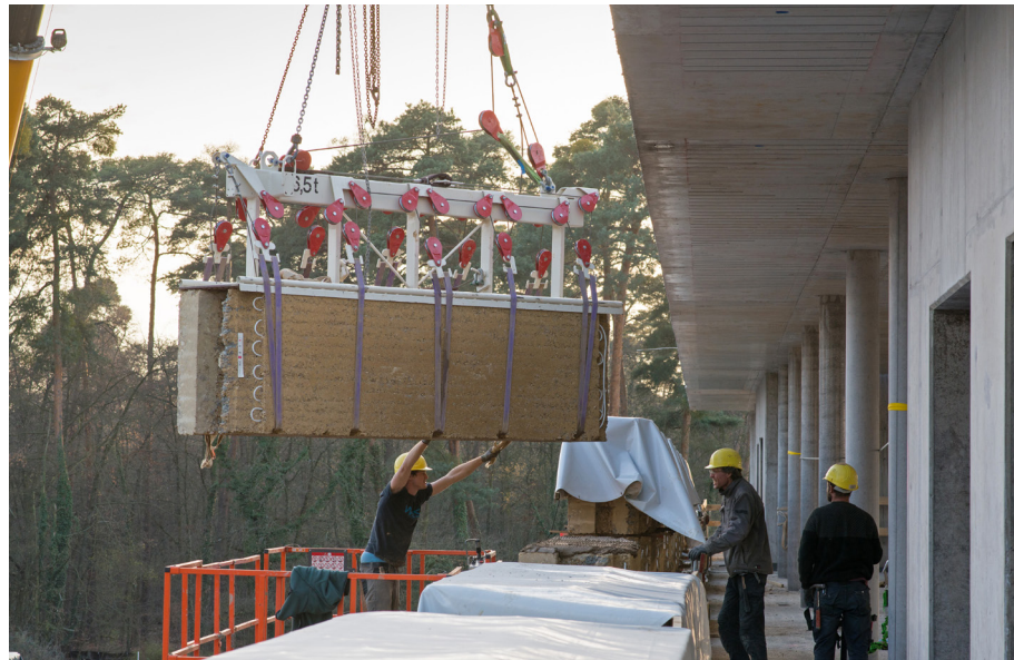
07 Versatz der vorgefertigten Stampflehmelemente
