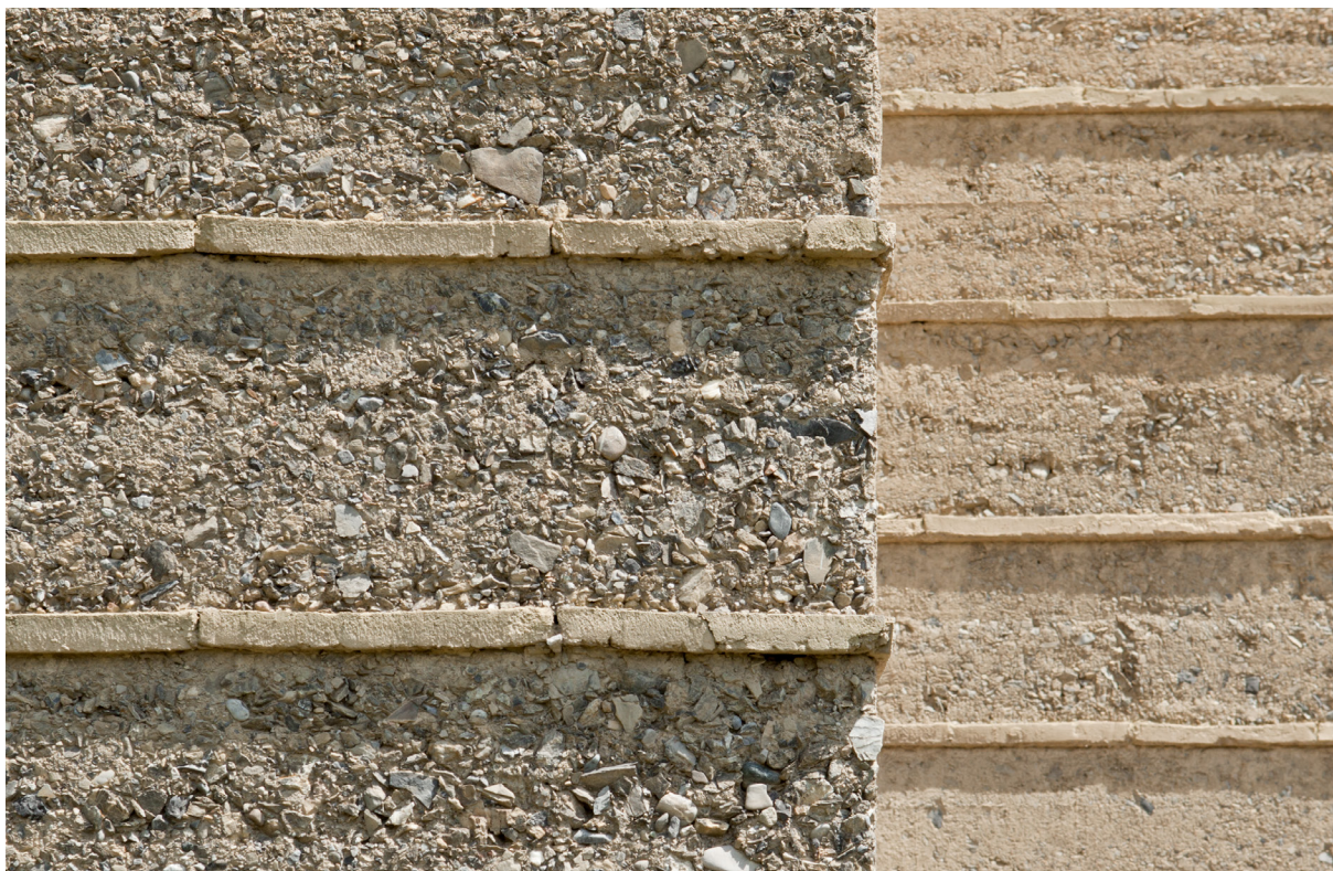
12 Kalkulierte Erosion: Die dem Wetter exponierte Fassade des Haus Rauch nach zwei Jahren Erosion
