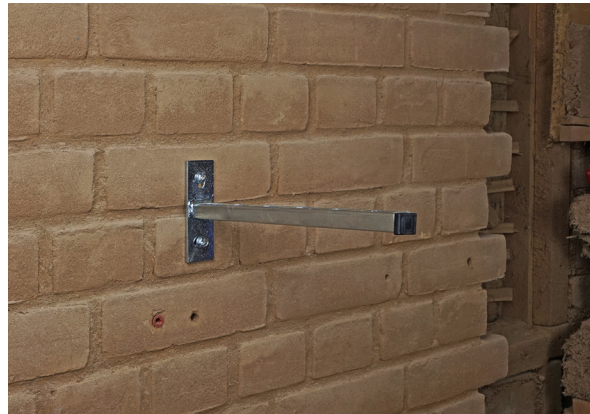
Tragkonsole in Lehmsteinmauerwerk
